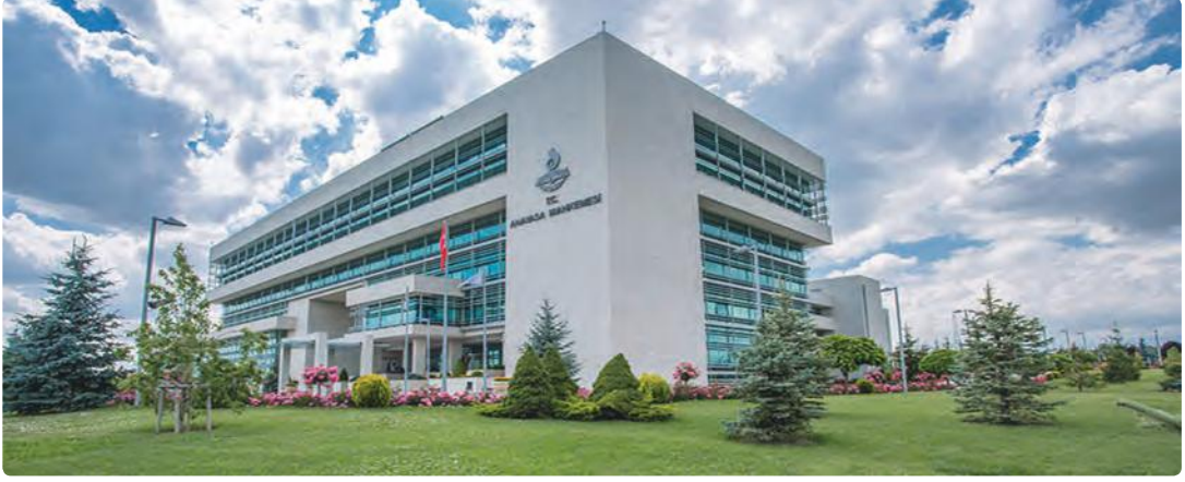
6.17: Anayasa Mahkemesi Binası
