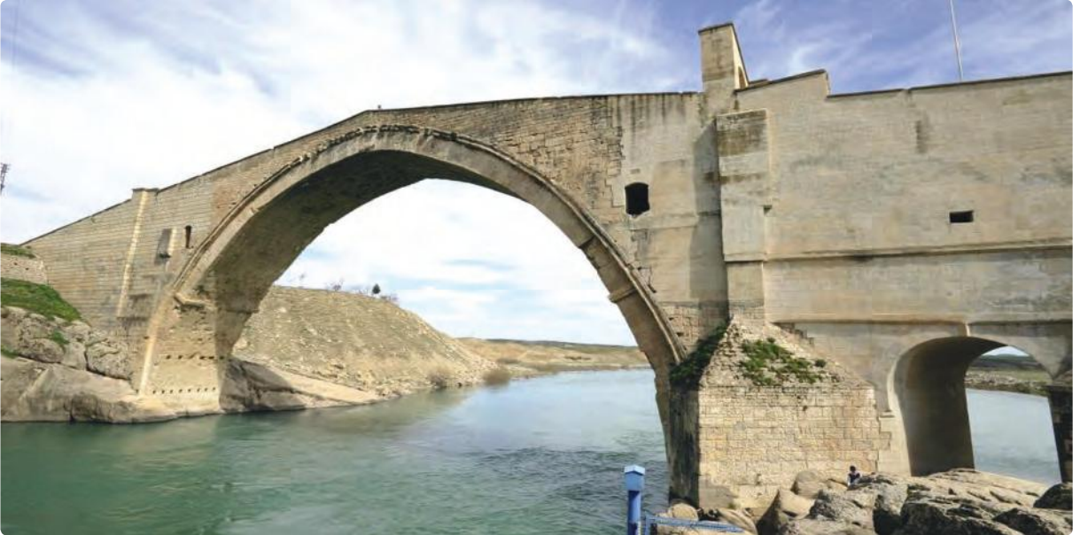
2.52: Malabadi Köprüsü-Diyarbakır: Timurtaş B. İlgazi B. Artuk tarafından Artukoğulları Dönemi’nde inşa ettirilmiştir.
