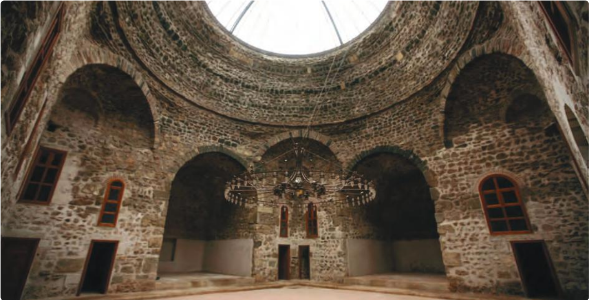
2.50: Yağıbasan Medresesi-Niksar-Tokat: Danışment Beyliği'nden Nizamettin Yağıbasan tarafından yaptırılmıştır.
